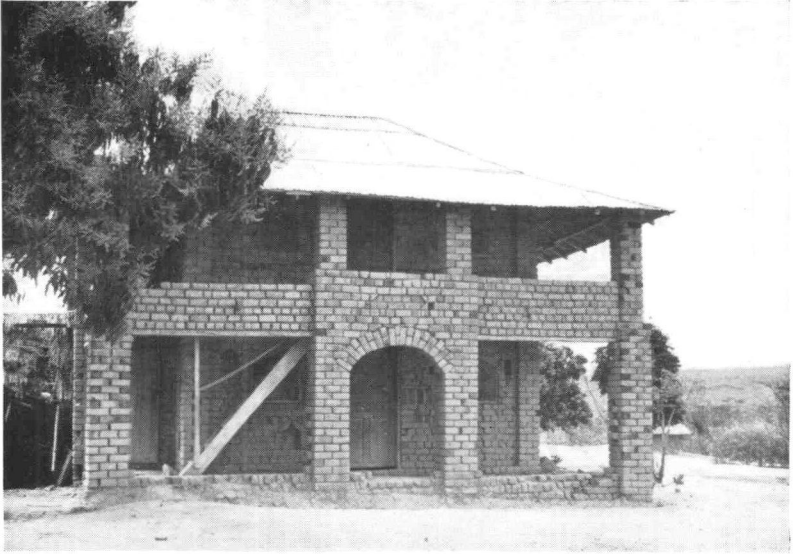
PHOTO 11. — Maison cossue à étage (village de Mbota, près de Luozi). Le caractère exceptionnel de ce bâtiment s'explique par les activités du propriétaire, commerçant habitant la ville mais originaire du village. La maison est occupée rarement.
