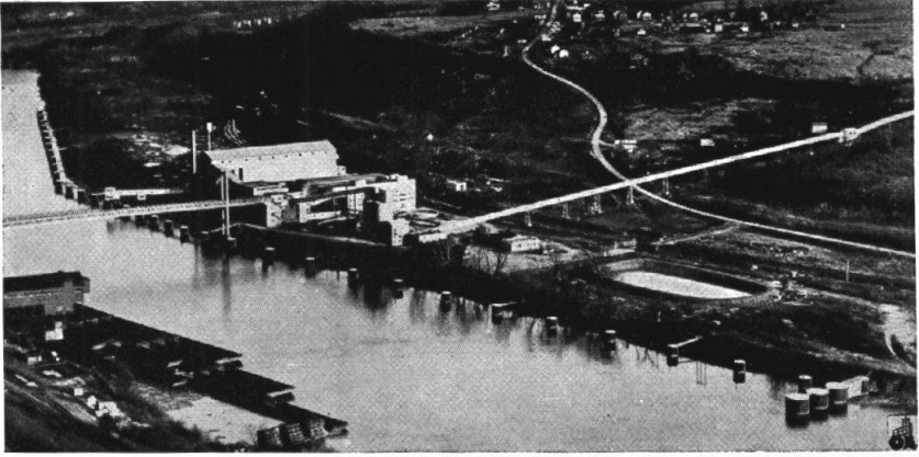
Fig. 4. — Postes d'accostage sur la Monanghahela.
