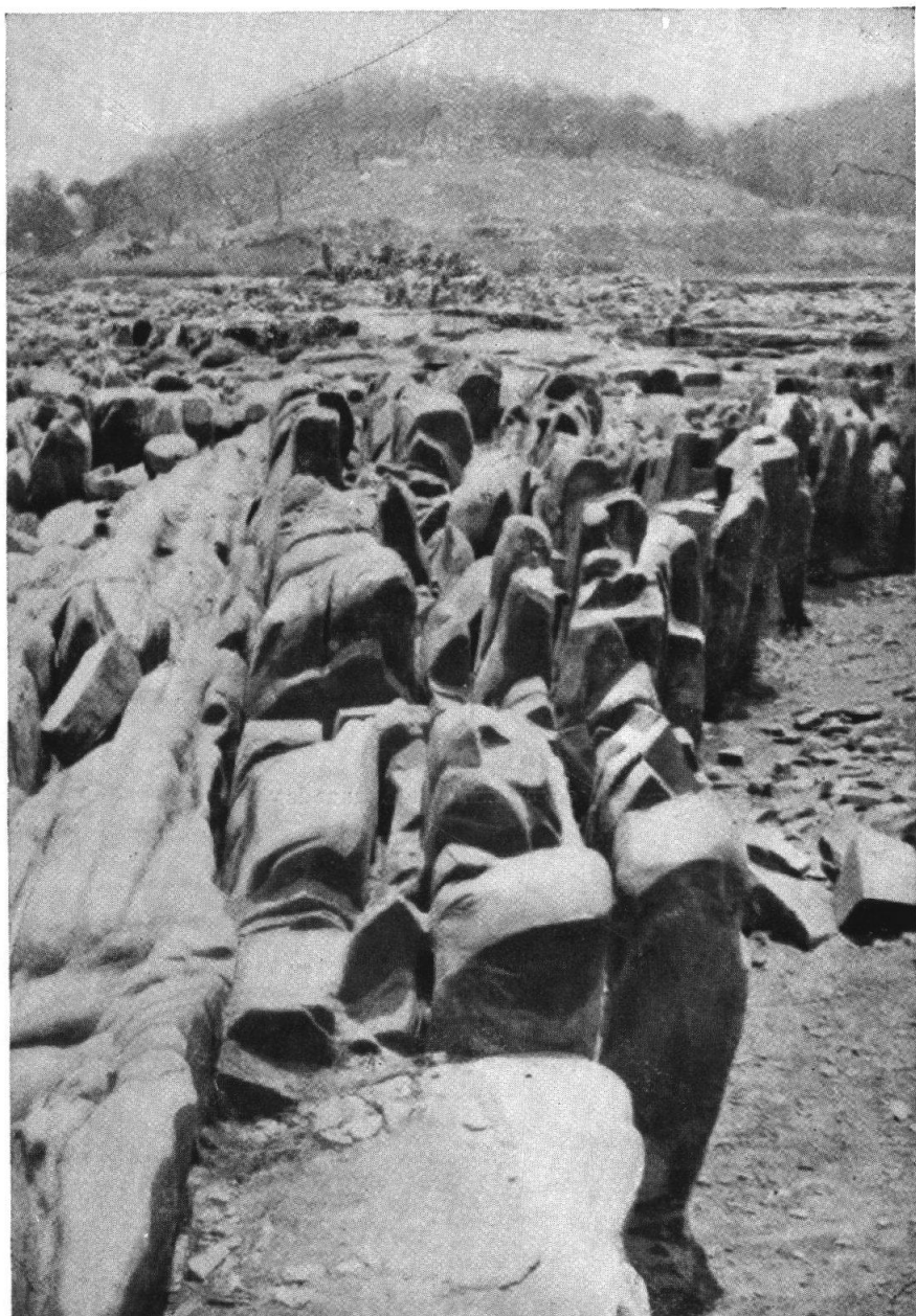
FIG. 2. — Aspect du sol dans l'axe du barrage.
