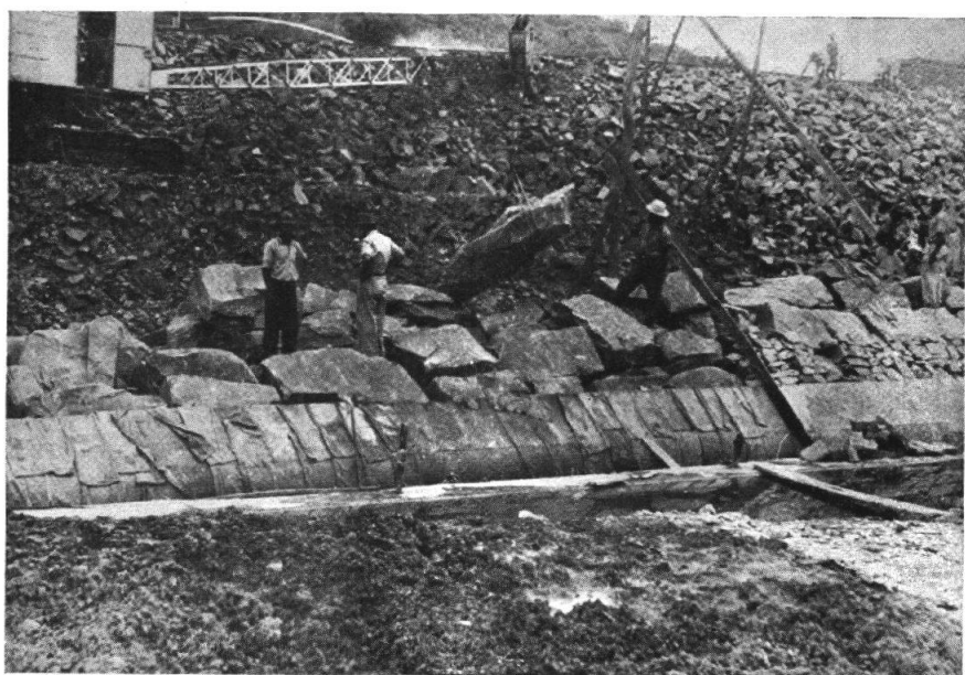
FIG. 9. — Mise en place des gros blocs du parement amont.
