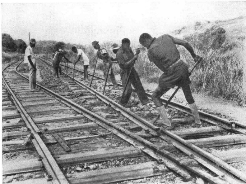
FIG. 1. — Mise à écartement des voies par une équipe de travailleurs indigènes.
