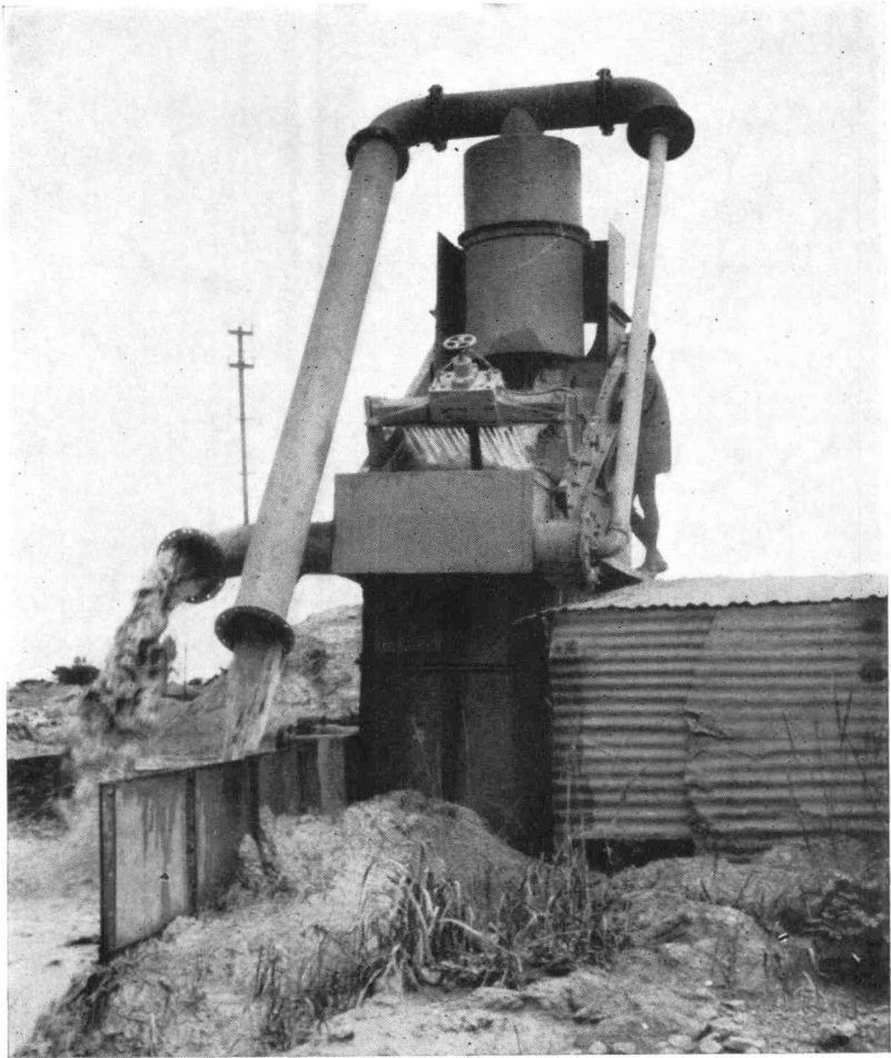
PHOTO 3. — Hydrocyclone de 32" et tamis vibrant Hummer 4' × 6' à la laverie de la Bisichi Tin Co. Ltd. (Nigérie).
